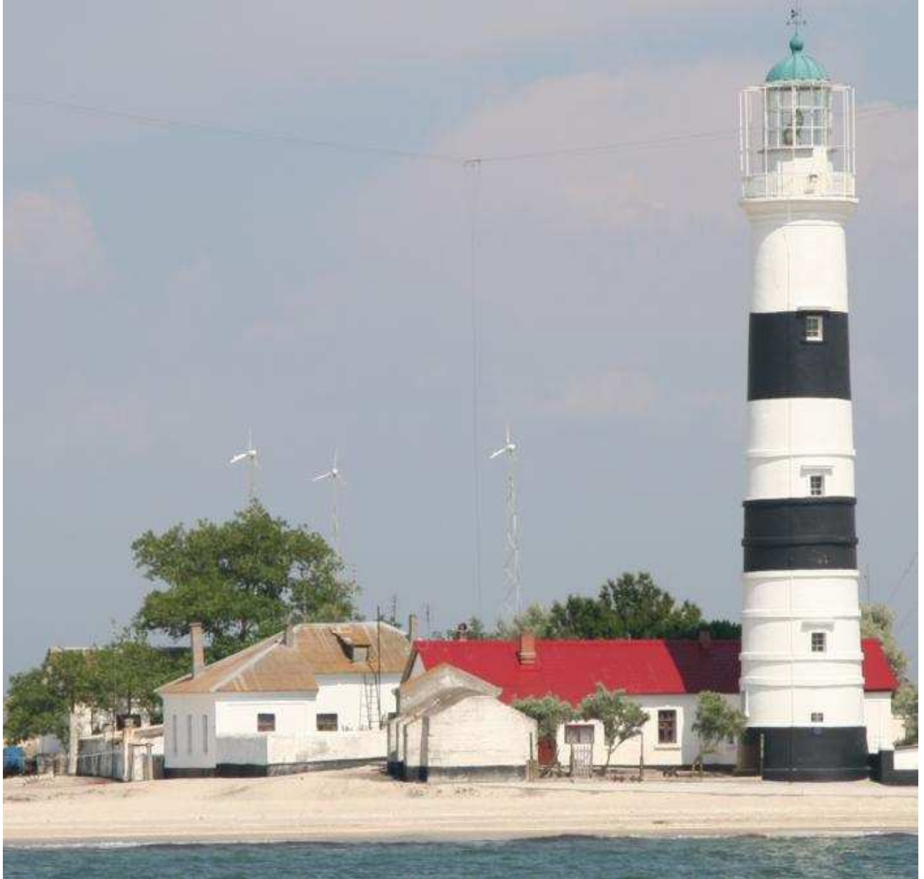
Рис. 10. Гибридная автономная система энергообеспечения маячного городка и аппаратуры маяка на Тендровской косе. Система состоит из 3-х ВЭУ-08 с мачтами высотой 17 м и 3-х СФЭМ мощностью по 120 Вт, прикрепленных к мачтам ВЭУ. Все ВЭУ и СФЭМ работают на один блок бесперебойного питания. Максимальная нагрузка на систему составляет 4 кВт.
