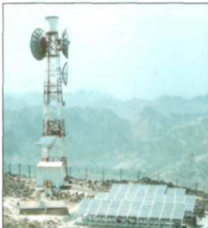
Рис.6. Гибридные системы энергоснабжения базовых станций сотовой связи на базе СФЭМ + резервный ДЭГ построены фирмой NAPS в странах Африки и южной Азии.
